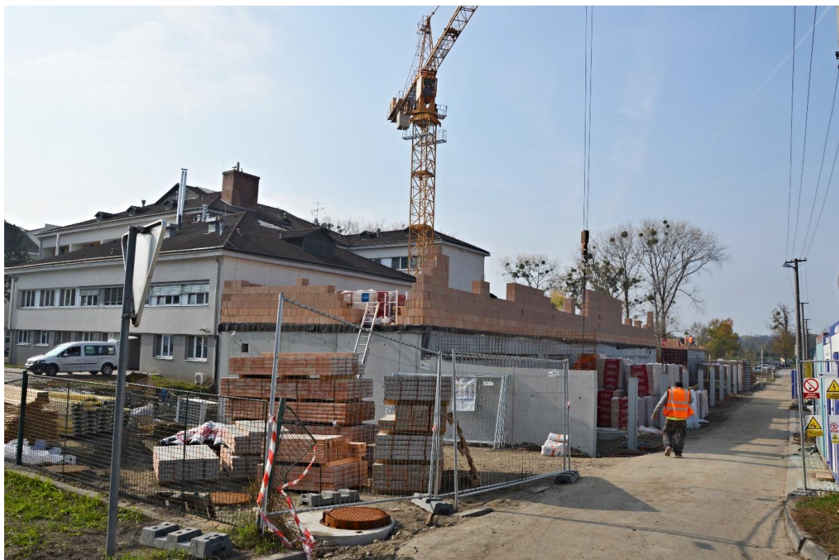
Přístavba Domova seniorů.
